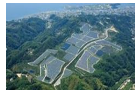
大規模太陽光発電所
