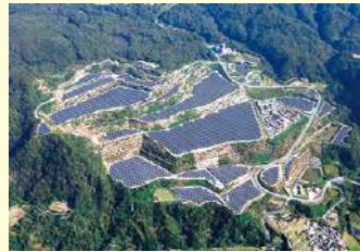
淡路市野島貴船地区(30MW)
