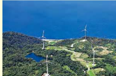
淡路市野島地区(2,000kw×6基)
