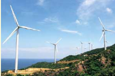
南あわじ市阿那賀地区(2500kw × 15基)
