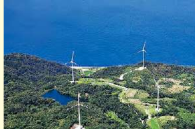
淡路市野島地区(2000kw × 6基)
