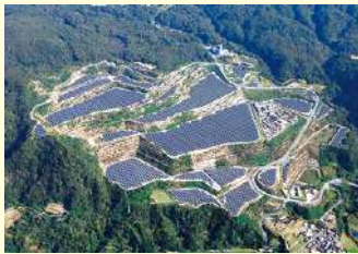
淡路市野島貴船地区 (30MW)
