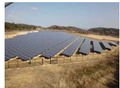
住民参加型太陽光発電所
