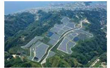
大規模太陽光発電所
