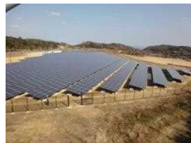
住民参加型太陽光発電所
